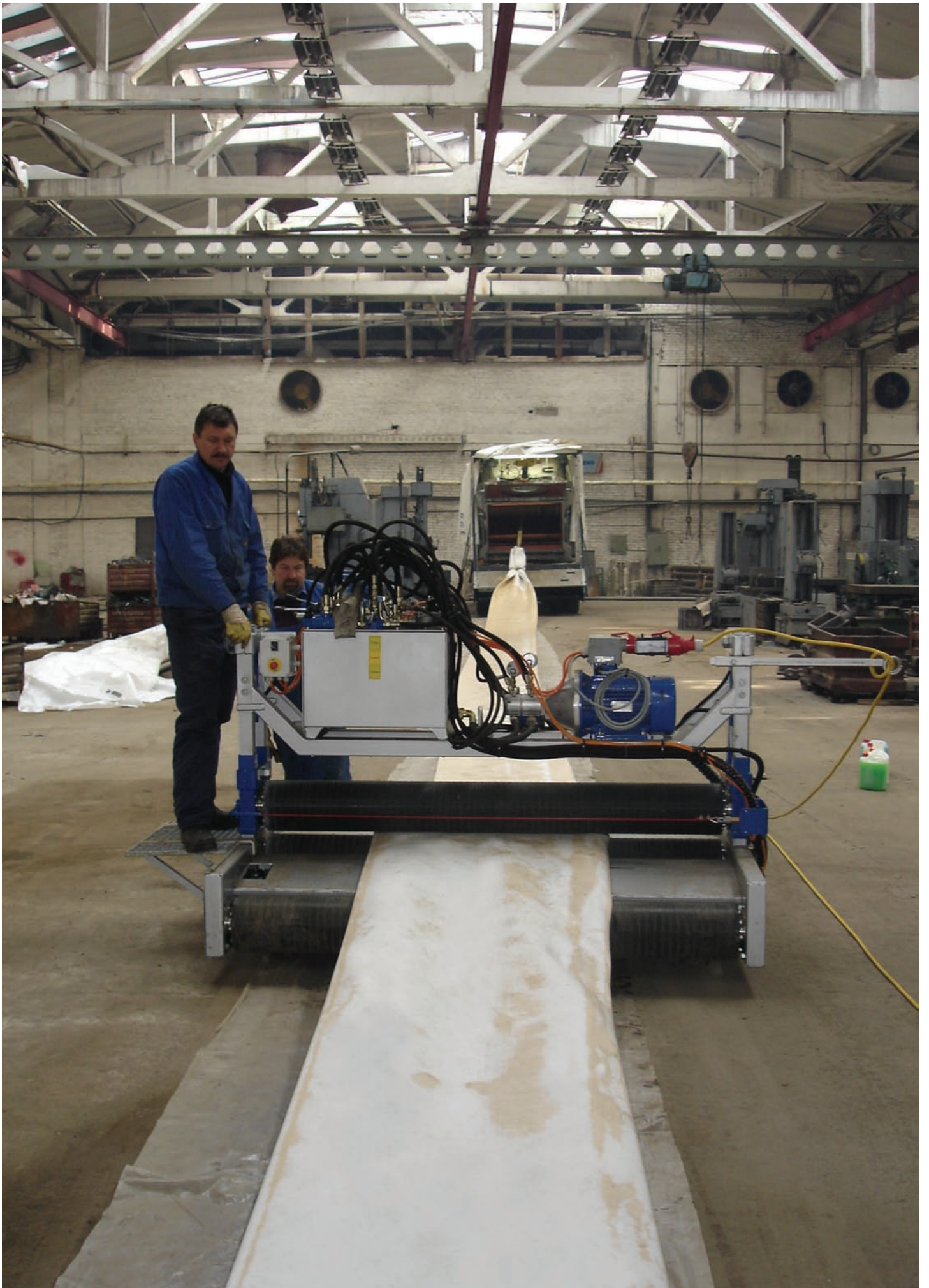
Nouveaux revêtements de conduites d'eau servant à transporter l'eau propre du Bug, en Europe de l'Est.
