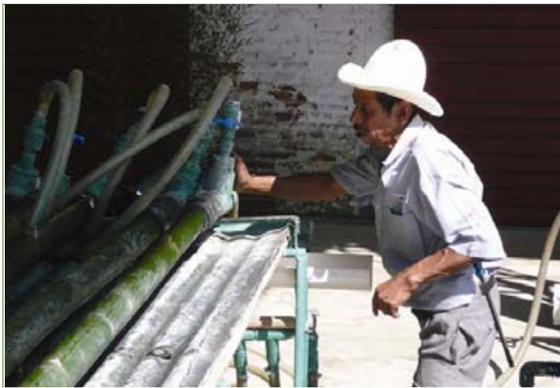
墨西哥工人安装竹子维护设备
