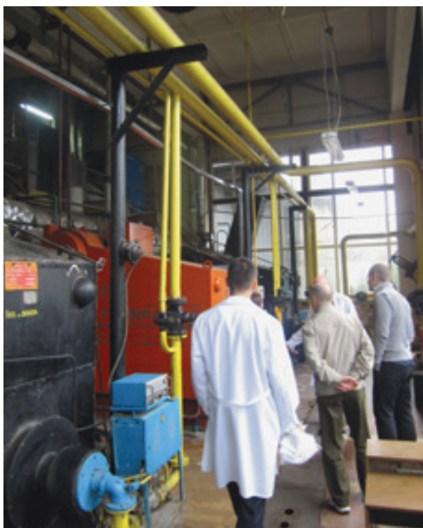
Installation d'échangeurs de chaleur dans une boulangerie industrielle en Ukraine
