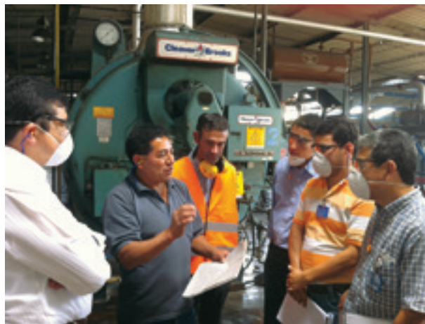
Un technicien chauffagiste en Équateur explique aux stagiaires les nouvelles pratiques opérationnelles introduites pour générer 25 % d'économies d'énergie.
