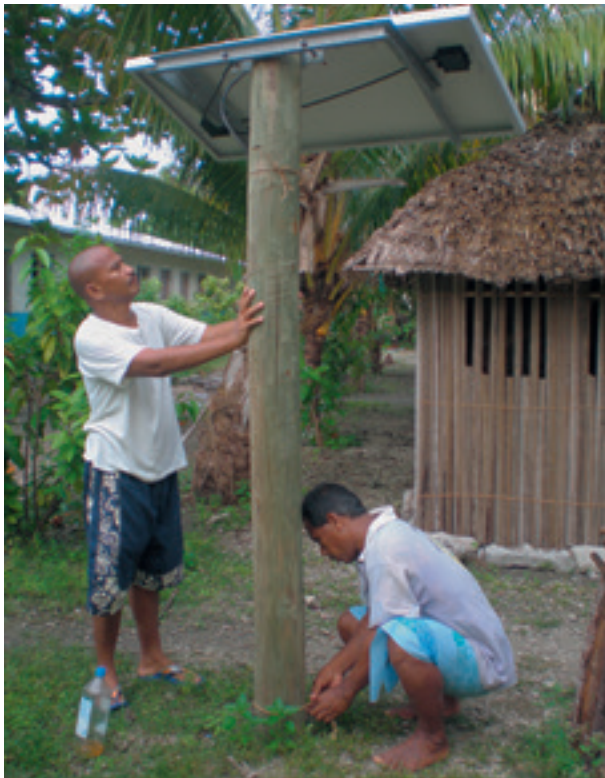
Installation de panneaux photovoltaïques dans une île du Pacifique
