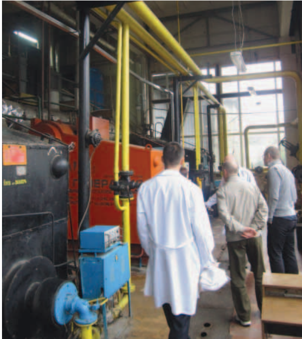
Установка теплообменников на одном из крупнейших хлебозаводов в Украине.
