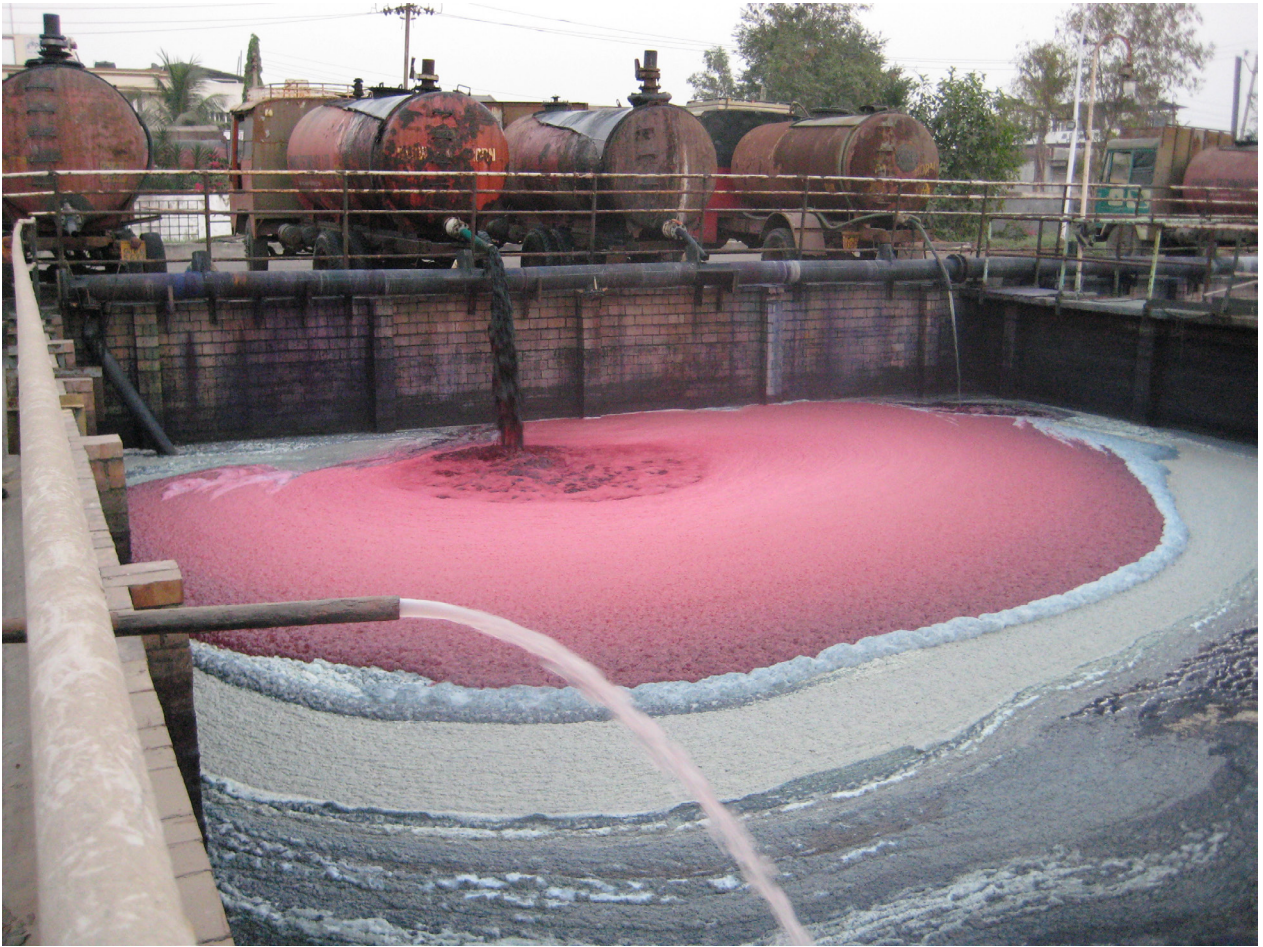
Effluent treatment India
