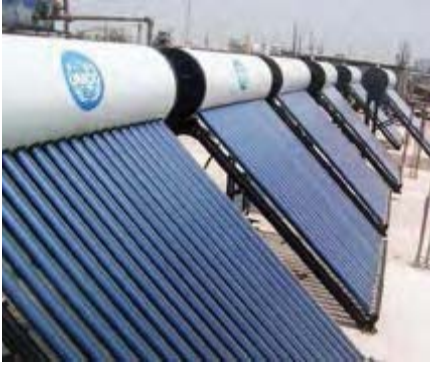
نظام تسخين المياه بالطاقة الشمسية في المدايح بنغلاديش.
