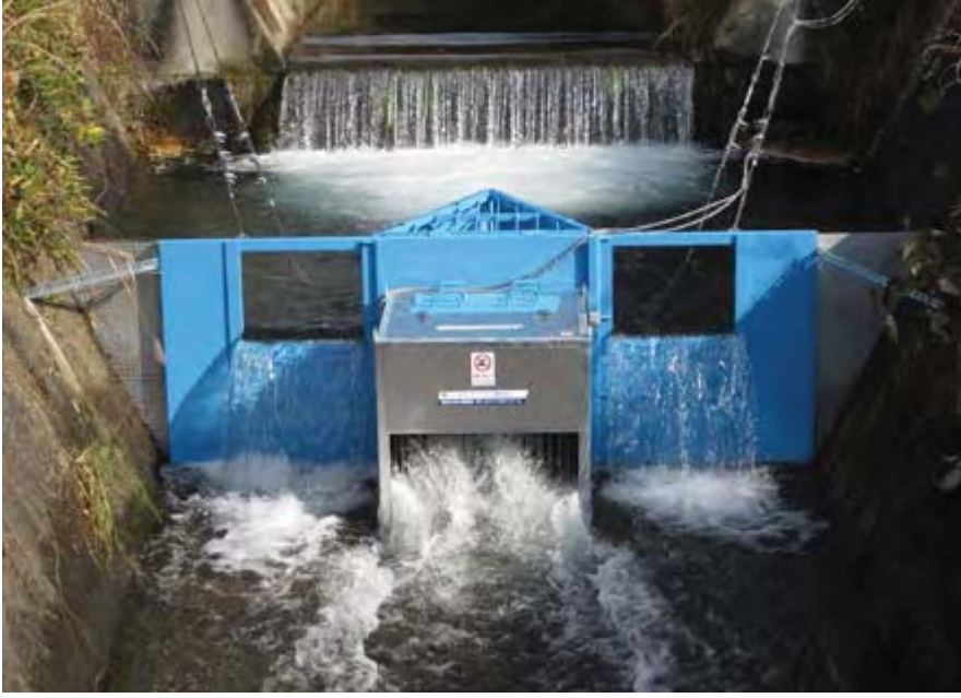
محطة للطاقة الكهرومائية الصغرى بمستوى سطح مياه بالغ الانخفاض في موبا، كينيا.
