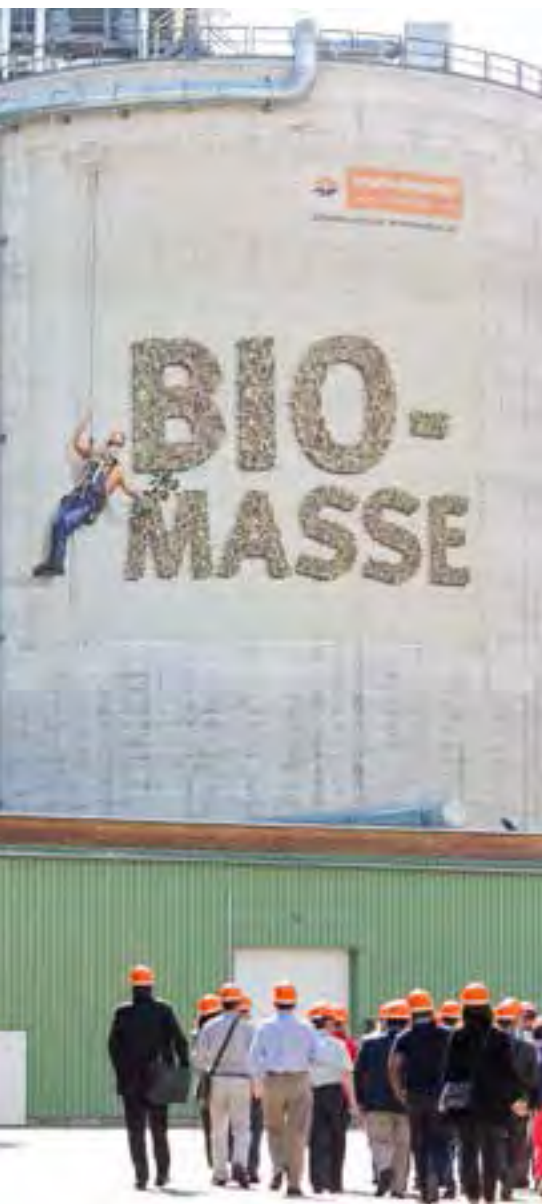
Forum de l'énergie de Vienne 2015: visite de terrain à l'usine de cogénération énergétique de Simmering à Vienne, qui produit de l'électricité et de la chaleur à partir de la combustion de plaquettes forestières © office@ludwigschedl.com
