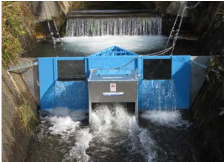
Microcentral hidroeléctrica de ultrabaja altura en Mwea, Kenya.
