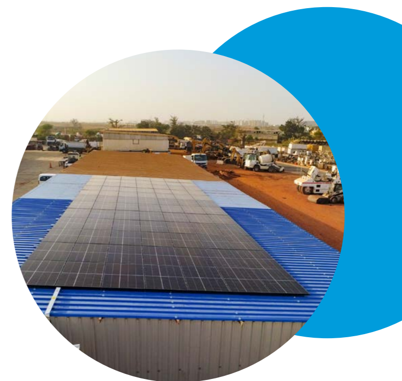
在 Eiffage Sénégal 安装太阳能电池板
